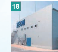
日本ゼオン株式会社 製造プラント建設 18
