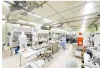
クリーンルーム Clean Room
