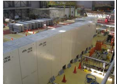
KEKつくばキャンパスに建設中のコンパクトERL(cERL)
