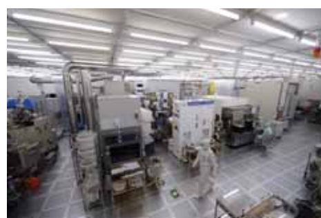
スーパークリーンルーム
